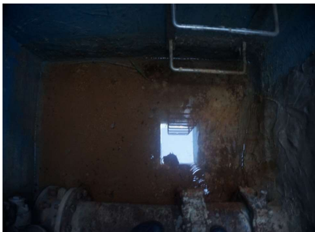
1지 유입밸브실 하부슬래브 채수
