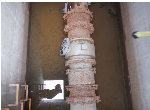
유입유량계실 하부슬래브 채수
