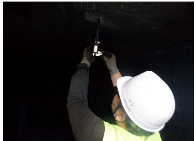
탄산화 깊이 측정
