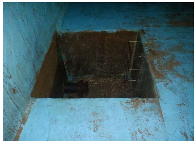
항내 집수정 진입 사다리 상태양호
