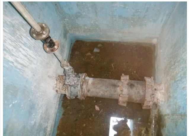
2지 유입밸브실 하부슬래브 채수
